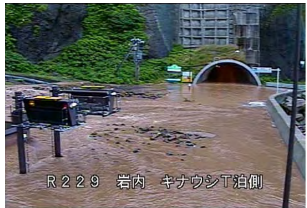
写真-1 被災状況（キナウシトンネル坑口 CCTV 画像）
