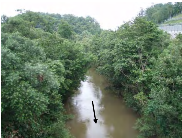
写真-1 樹木繁茂状況 (KP16.6 真栄橋から上流)
