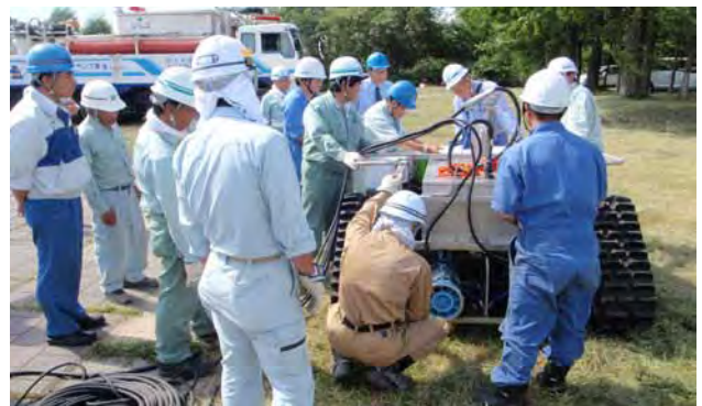
写真-16 排水ポンプ搭載作業状況
