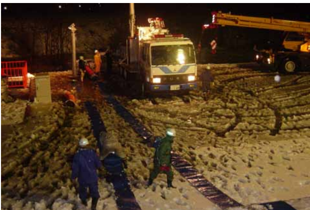
写真-1 平成19年1月十勝太での排水作業
