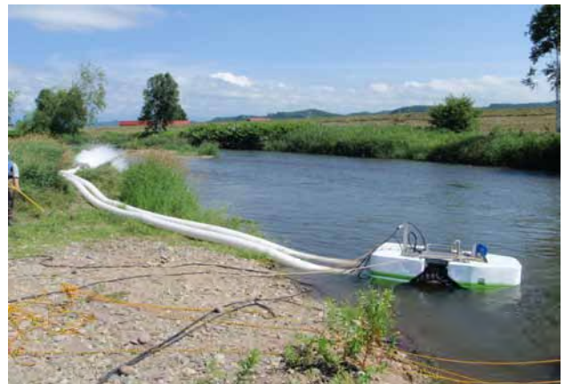
写真-13 進水状況
