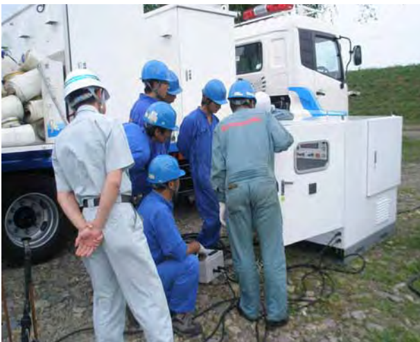
写真-15 操作盤接続作業状況
