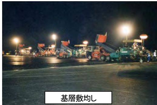
写真-3 第2工程施工状況
