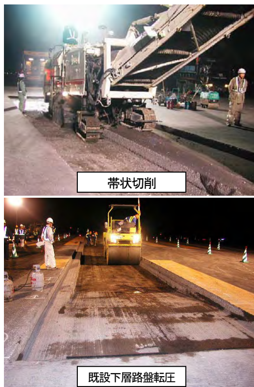
写真-2 第1工程施工状況
