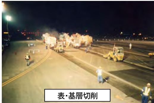
図-4 第2工程施工手順
