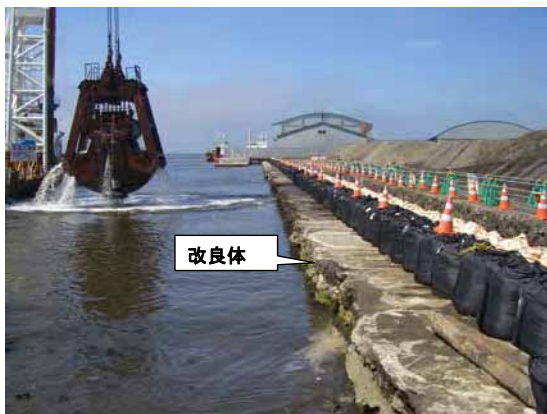
写真-2 旧岸壁の取り壊し掘削状況
