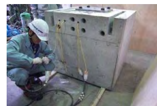
写真10 支承交換破砕前
