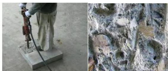
写真 3 コンクリートブレイカー工法とそのはつり面
