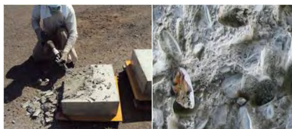
写真 2 電動ピック工法とそのはつり面
