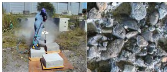
写真 1 WJ 工法とそのはつり面
