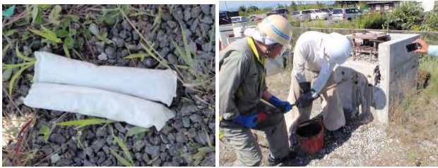
写真13 静破碎剤および設置状況
