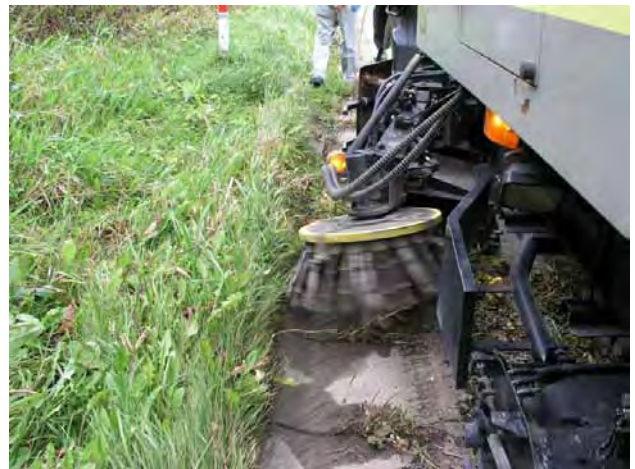
写真-20 皿形側溝除草作業状況
