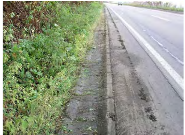
写真-21 皿形側溝除草作業後状況
