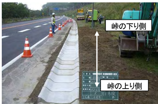
写真-1 6合目付近における試験施工状況
