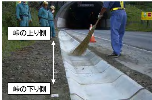
写真-2 7合目付近における試験施工状況
