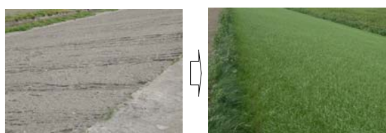
図-9 石灰安定処理土表面における泥炭張付後の種子散布状況
