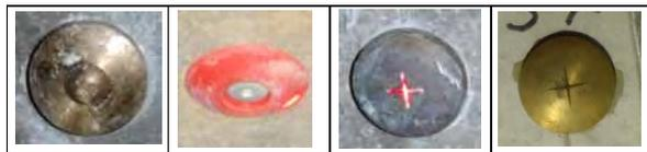
写真-6 実樋門・樋管に使われていた測定鈎
