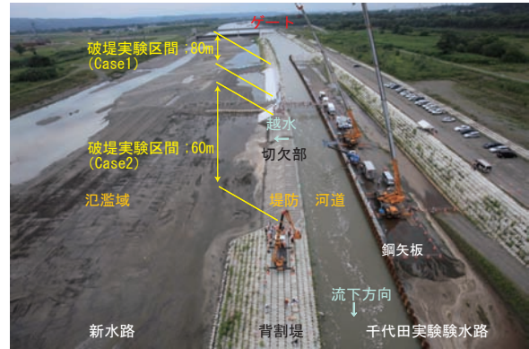
図-1 千代田実験水路における越水破堤実験の様子 (Case2)
