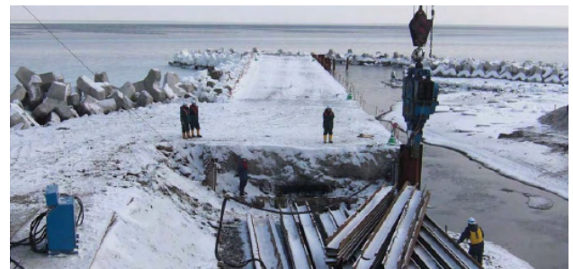
図-6 試験施工状況
