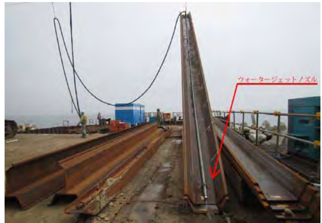
図-13 ウォータージェット装着状況
