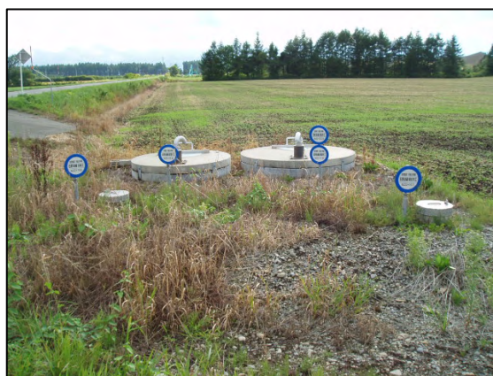
写真-2 地上部施設の状況
