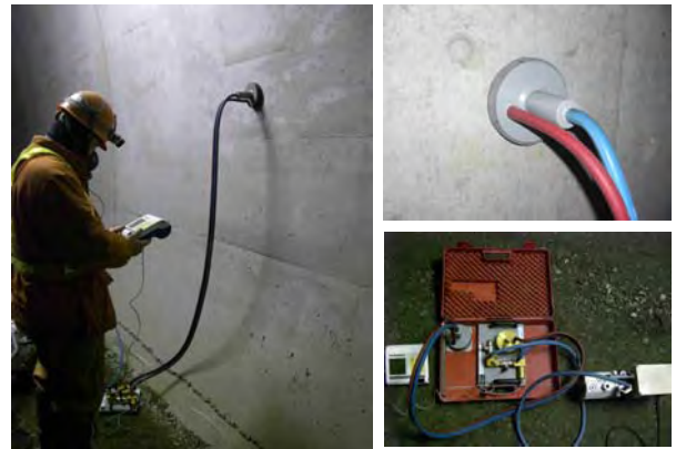
写真-2 透気係数測定状況
