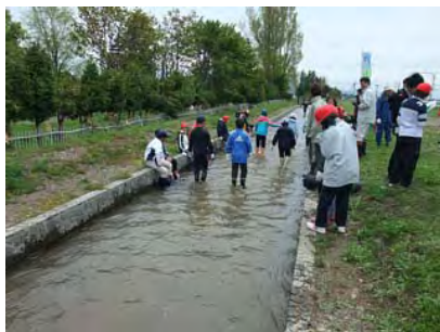
写真-7 自然石護岸用水路 (新雨竜地区)
