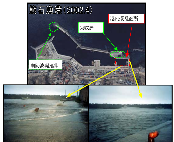
写真-2 港内擾乱状況（岸壁越流・水面盛り上がり）
