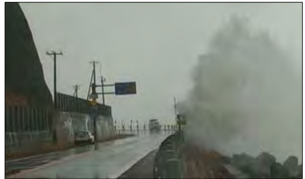
写真-1 海岸道路の越波状況の例
