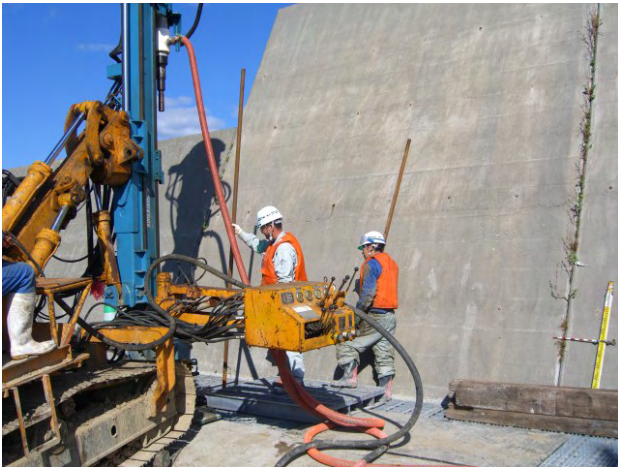
写真-4 削孔及び注入管設置状況
