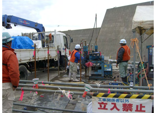
写真-6 グラウト注入状況
