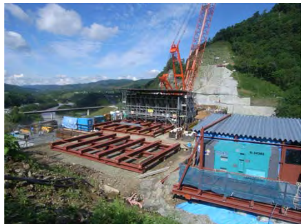
写真-3 地組ヤード
