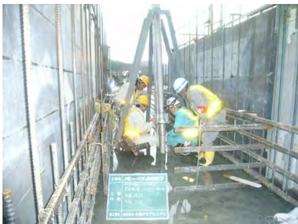
写真-12 鉄筋と空気配管
