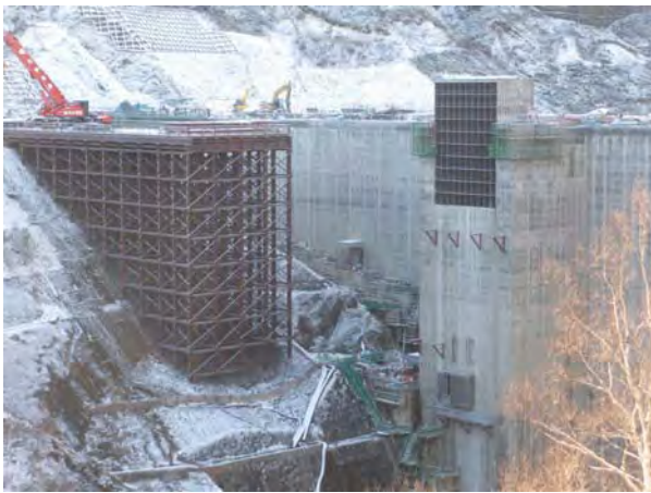
写真-1 取水管12段据付完了
