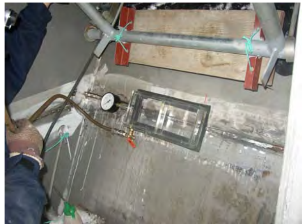
写真-8 取水管真空引き試験
