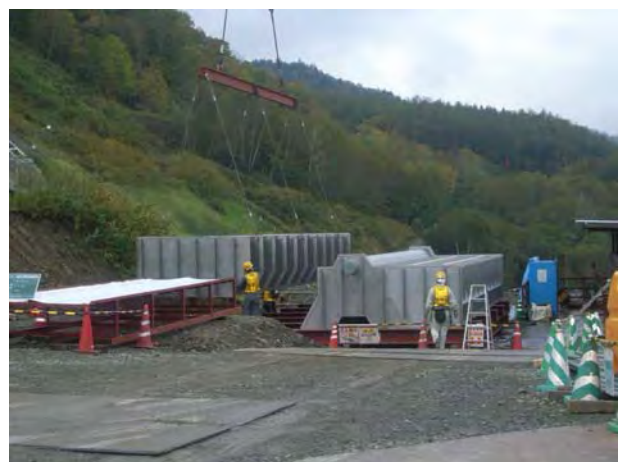
写真-4 地組立状況
