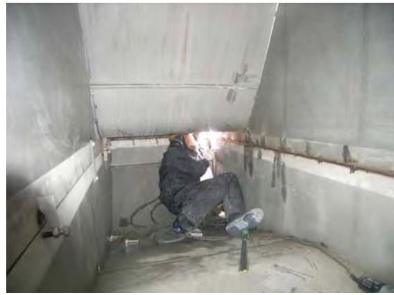
写真-7 溶接状況
