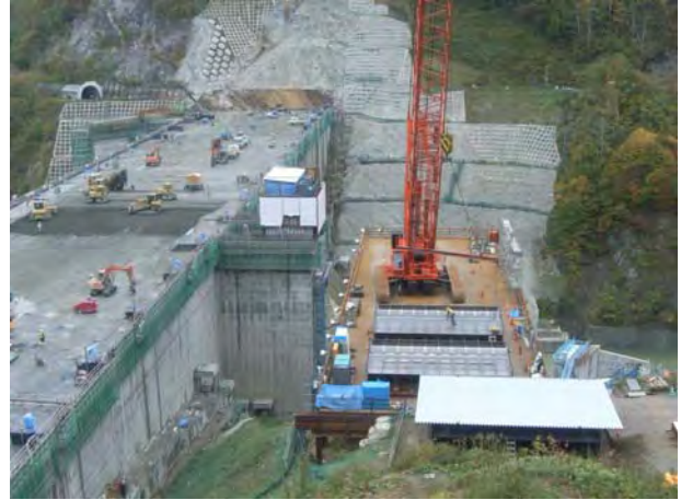
写真-2 仮設構台
