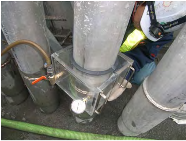
写真-10 空気配管真空引き試験
