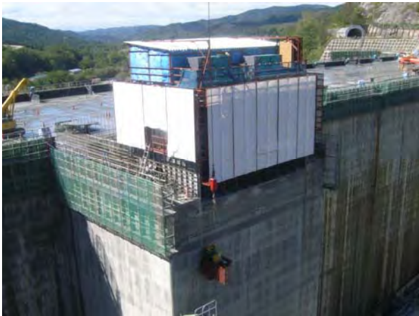
写真-5 上部作業小屋とスライド足場
