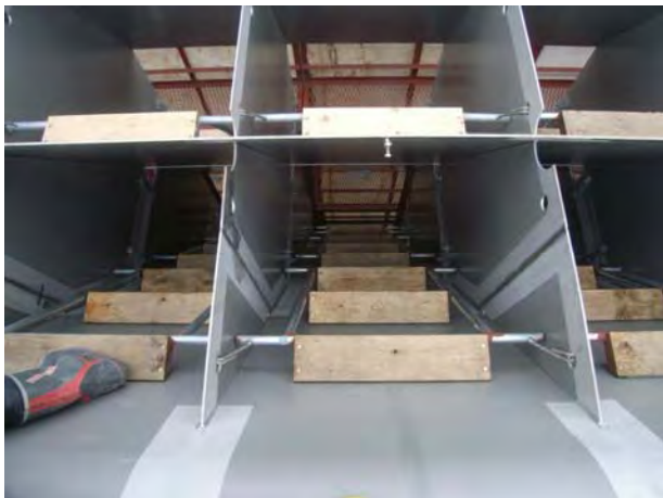
写真-6 内部足場
