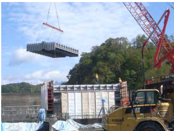
写真-11 取水管吊り込み
