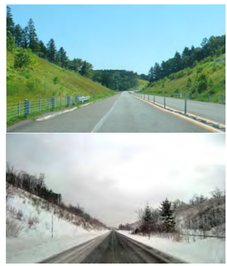
写真-3 のり面勾配を緩くする対策
