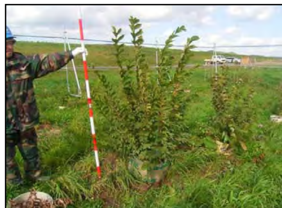
写真-4 萌芽幹発生・円筒形型枠を使用した土掛け盛土
