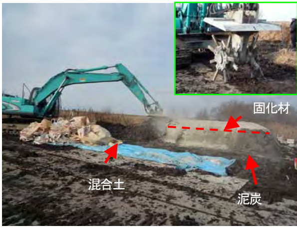
写真-1 ロータリー式スタバイライザによる攪拌混合
