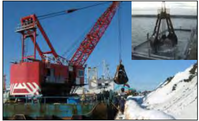
写真-3 クラムシェルによる積込・投入状況
