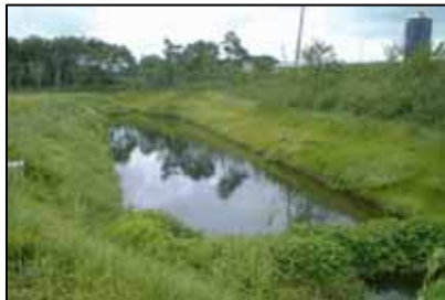
写真-3 排水調整池の整備状況
