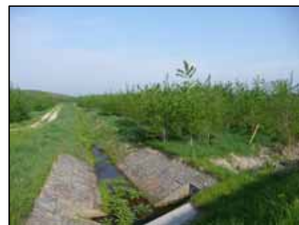
写真-1 土砂緩止林の整備状況
