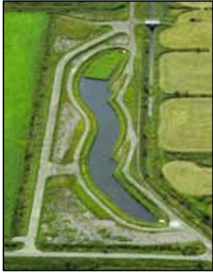
写真-2 遊水池の整備状況
