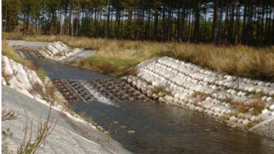
写真-10 植生状況
