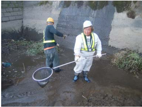
写真-7 既設落差工で魚類確認
