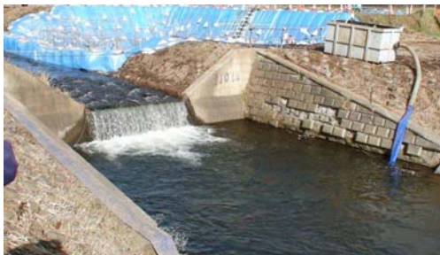
写真-4 既設段落型落差工
