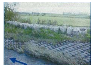
写真-3 大型土のうによる応急対応
