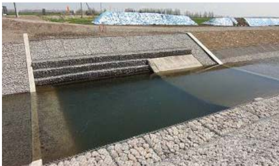
写真-8 魚溜まり工
