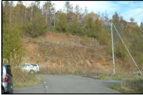
写真-3 地点番号33の法面の現状
