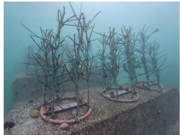
写真一1 人工海藻設置写真
