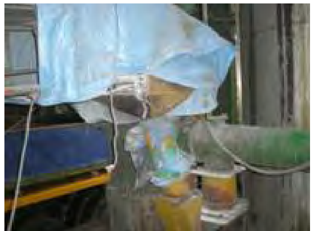
写真-6 石粉エレベータへの投入
