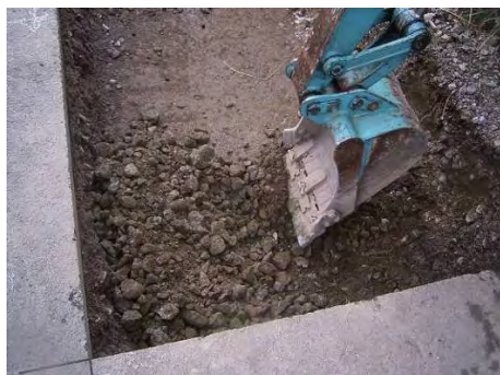
写真-12 セメントコンクリート再生骨材(凍上抑制層)
