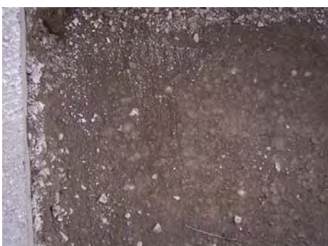
写真-13 セメントコンクリート再生骨材(凍上抑制層)
