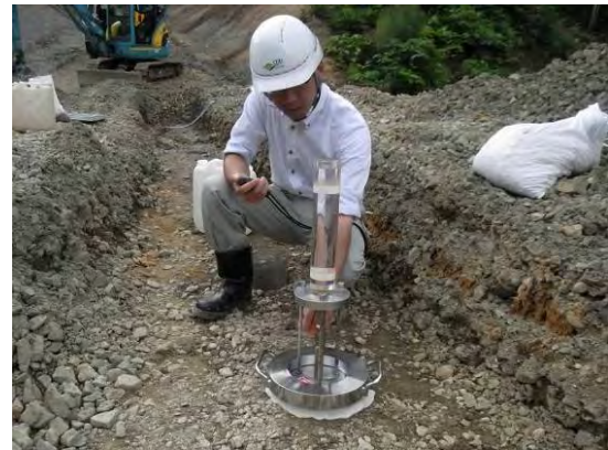
写真-4 現場透水量試験（舗装用透水試験器）
