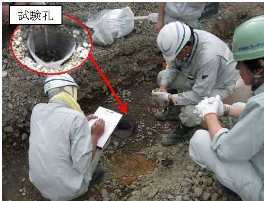
写真-3 現場透水量試験（変水位法）
