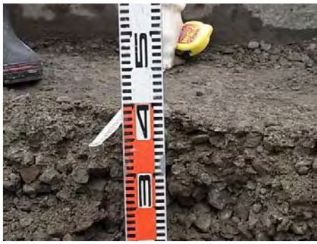
写真-10 セメントコンクリート再生骨材(下層路盤)
