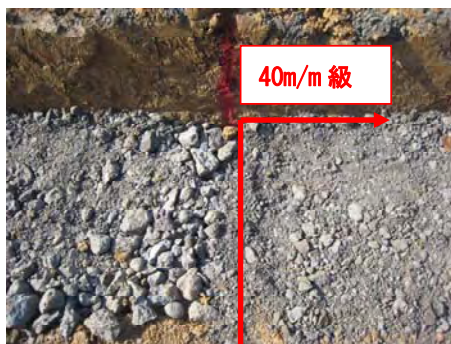
写真-9 4 工区 再生骨材(40m/m 級)
