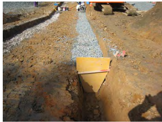
写真-2 路床排水の施工断面
