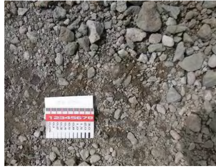
(左：施工直後 右：施工 10 ヶ月後)
