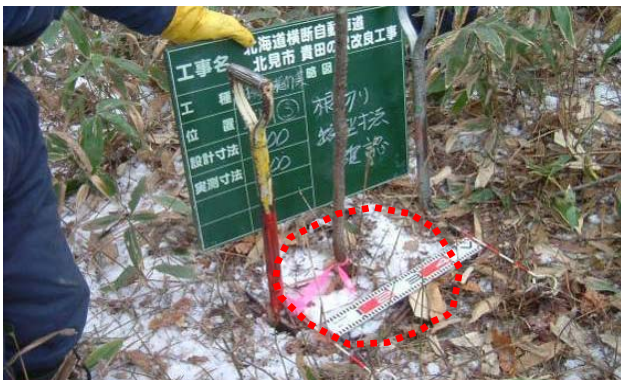
写真-4 根廻し据え置き法実施後状況写真
