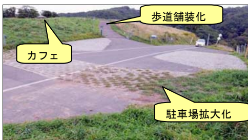
写真－8 充実した移動施設
