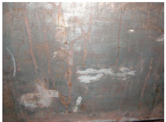
写真-12 はく離塗膜除去後 (2回目 完了)
