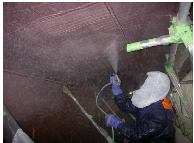
写真-5 はく離剤の塗布状況(上向き作業)
