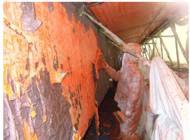
写真-6 はく離した塗膜の除去状況
