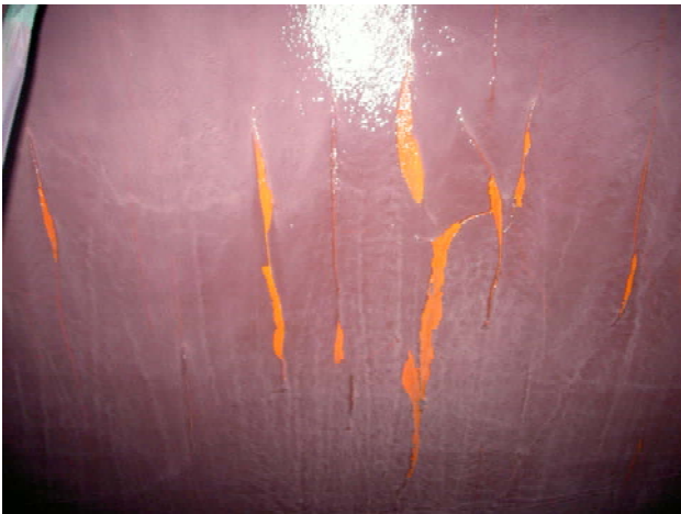
写真-8 はく離剤塗布後 (1回目 8時間経過) (気温 9.1℃、湿度 28%)
