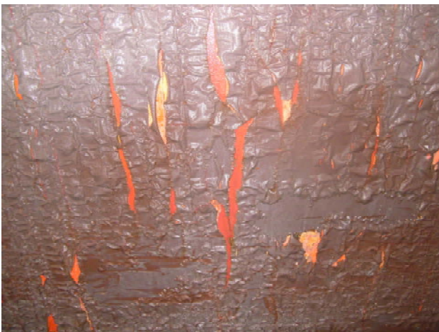
写真-9 はく離剤塗布後 (1回目 154時間経過) (気温 4.1℃、湿度 83%)
