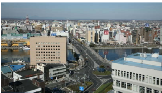
写真－1 幣舞橋の全景
