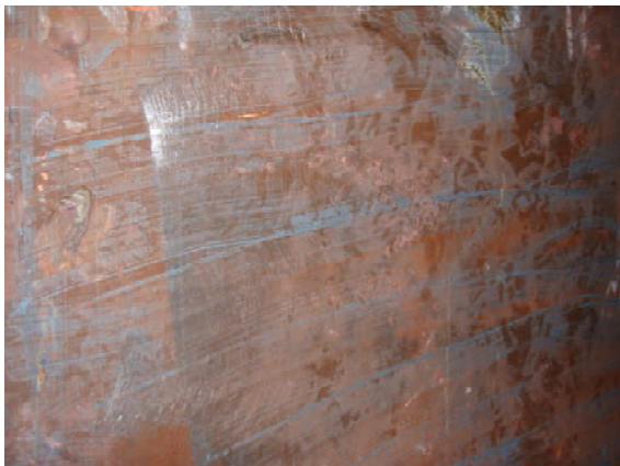
写真-13 はく離剤素地調整後の残存塗膜 (2 回塗布はく離後 茶色部分が残存塗膜)
