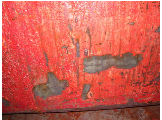
写真-11 はく離剤塗布後 (2回目 92時間経過) (気温 22.1℃、湿度 29%)
