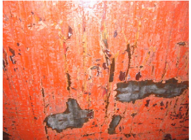
写真-10 はく離塗膜除去後 (1回目 完了) (気温 7.9℃、湿度 93%)
