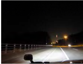
写真-6 線形誘導機能を発揮する防護柵
