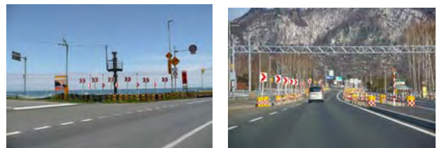
写真-2 道路の線形や屈曲の度合いを示す標示板の設置例
