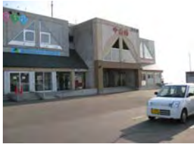
写真-1 駅舎が車道・駐車場が直接つながり外に休憩場所が無い事例
