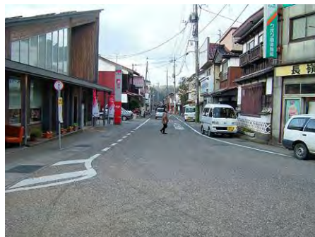
写真-7 整備前の本町・祇園丁通り（津和野町、島根）
