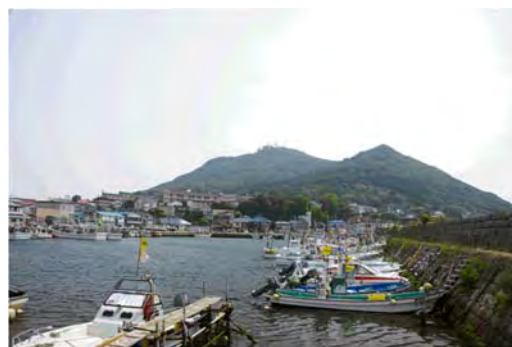
写真-3 函館漁港船入潤防波堤
