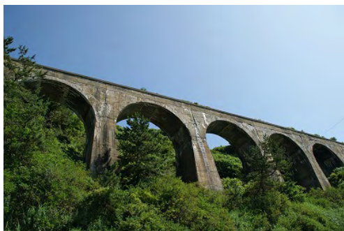
写真-1 旧戸井線アーチ橋
