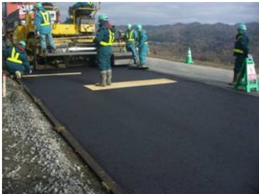
写真-2 温度測定状況
