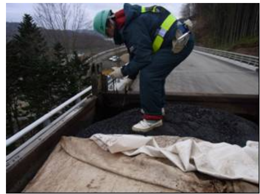
写真-1 到着時の温度測定状況
