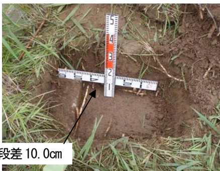
写真-2 現地踏査結果 状況写真
