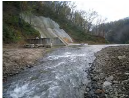
b) 改良後（上流より撮影）
