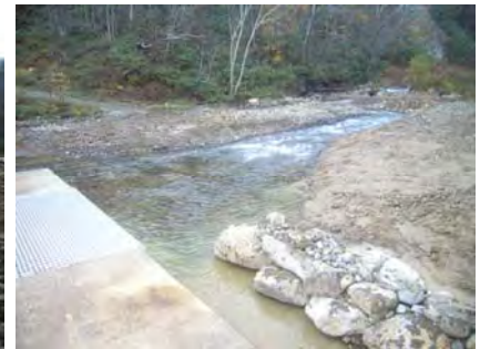
c) 改良後（下流より撮影）
