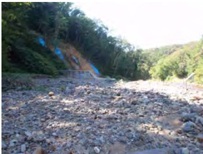
a) 改良前（上流より撮影）
