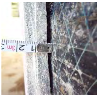
写真-5 浮き高さの確認
