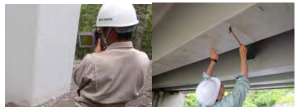
サーモグラフィ調査
