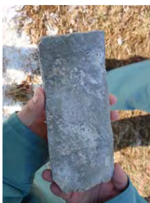
写真-6 保護材と繊維シートとの接着状況
