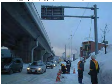
図-1 人力による雪下とし作業状況
