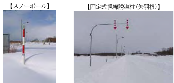
図1 視線誘導施設の設置状況
