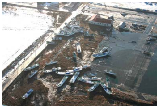
写真-2 2011年東北地方太平洋沖地震による大津漁港の被害状況(出典：十勝毎日新聞)
