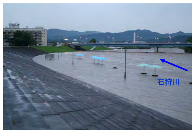
写真-1 平成23年9月石狩川出水状況（旭橋下流）
