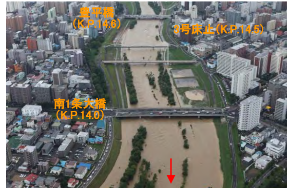
写真 4-1 平成 23 年出水状況 (6 日 15 時頃, KP14.0 付近)
