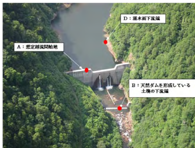
写真-3 訓練の計測箇所 (戸蔦別川第8号砂防堰堤)
