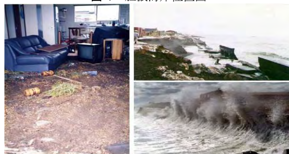
写真-1 1994年の高波による越波・浸水被害状況
