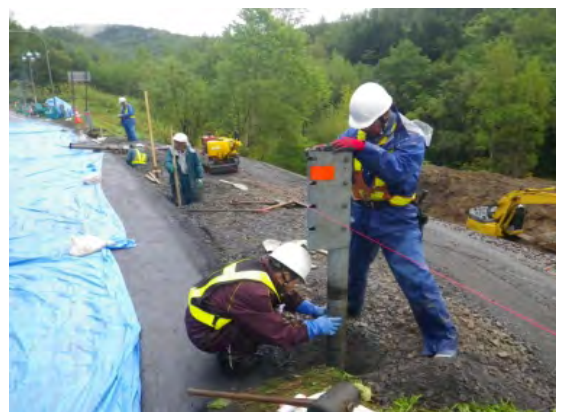
写真-8 9月12日早朝 道路付属物工
