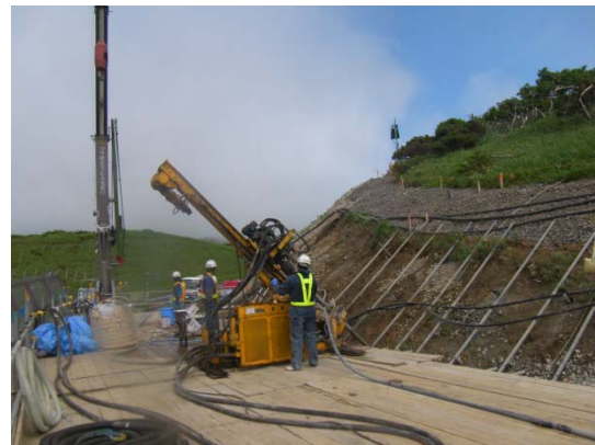
写真-7 ロックボルト施工状況
