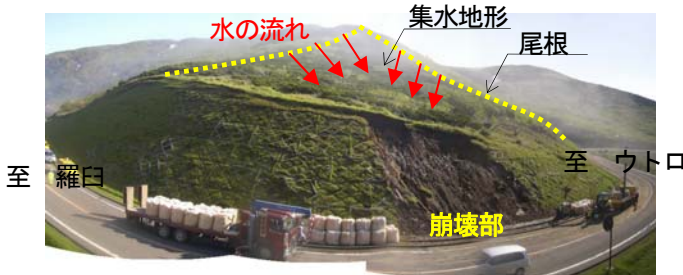
写真-2 工事箇所全景
