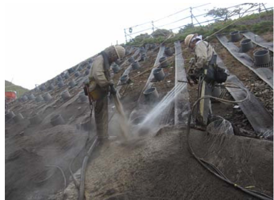
写真-8 連続繊維補強土工施工状況
