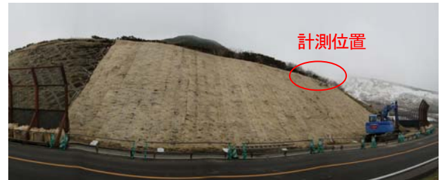
写真-9 復旧状況全景写真
