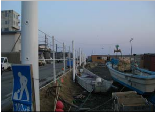
写真-7 津波漂流物の補足状況の例（えりも港）
