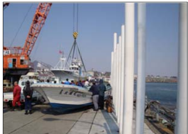
写真-6 津波漂流物の補足状況の例（十勝港）
