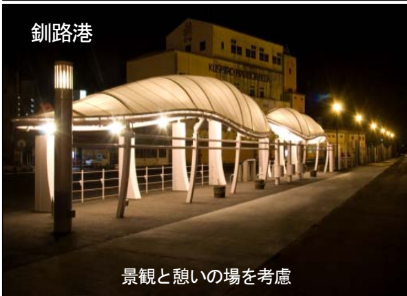
写真-2 北海道における津波漂流物対策施設（直轄）
