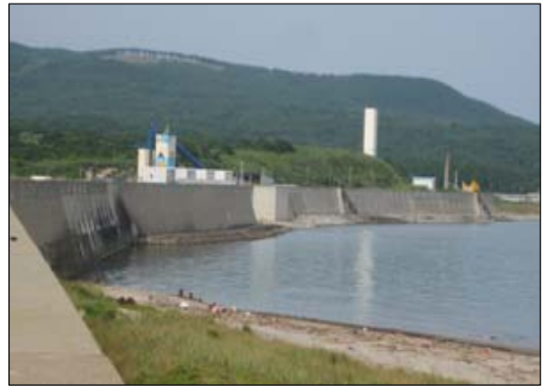
写真-3 防潮堤の例（奥尻町富里地区）
