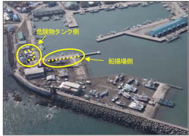
写真-4 十勝港（南地区）の整備箇所
