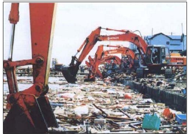
写真-1 津波漂流物による被害の例(北海道南西沖地震時)
