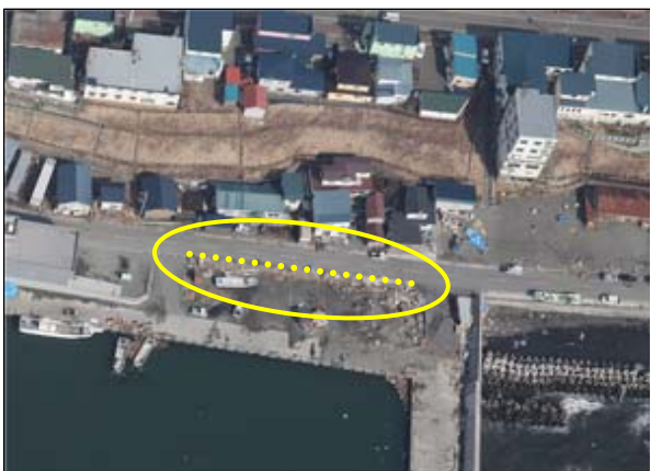
写真-5 えりも港（本港地区）の整備箇所
